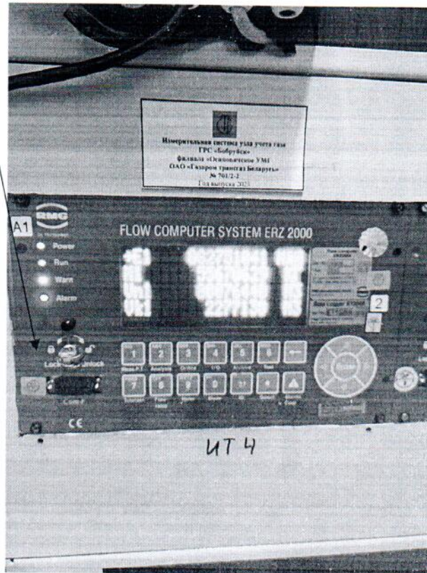
Рисунок 3.1 – Схема пломбировки от несанкционированного доступа
