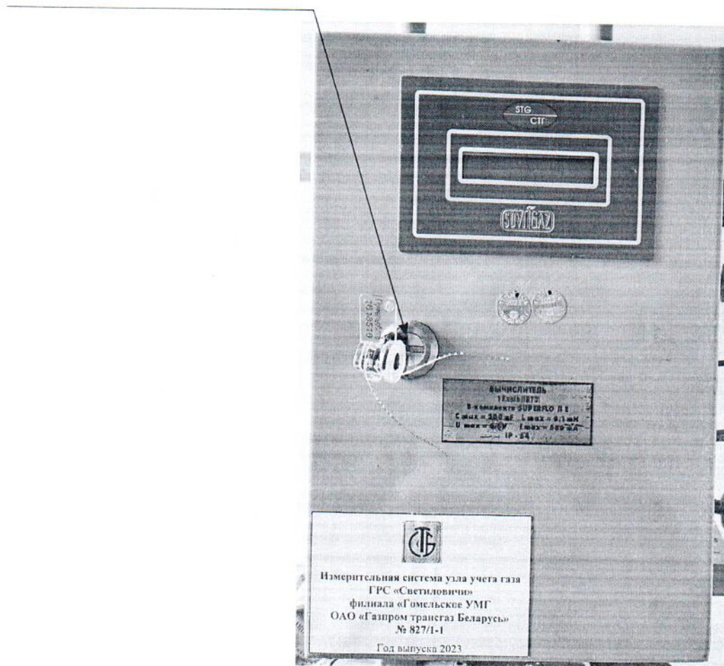
Рисунок 3.1 – Схема пломбировки от несанкционированного доступа
