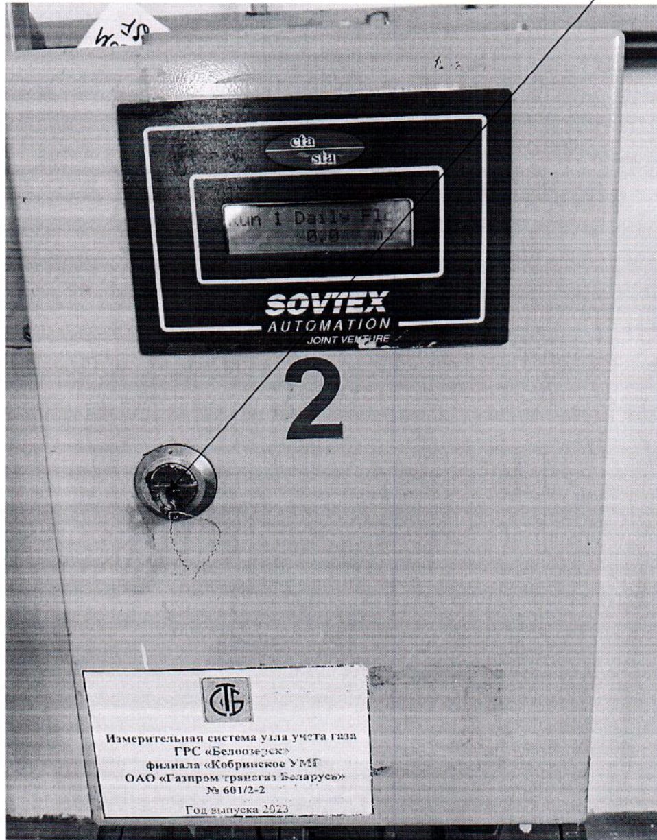
Рисунок 3.1 – Схема пломбировки от несанкционированного доступа
