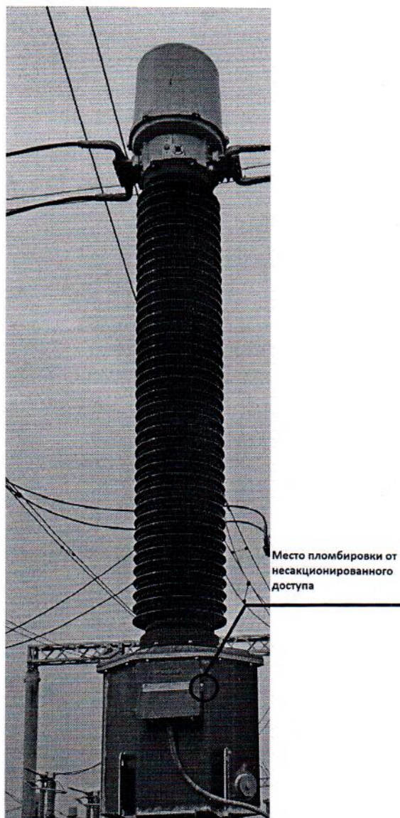
Рисунок 3 - Схема пломбировки от несанкционированного доступа
