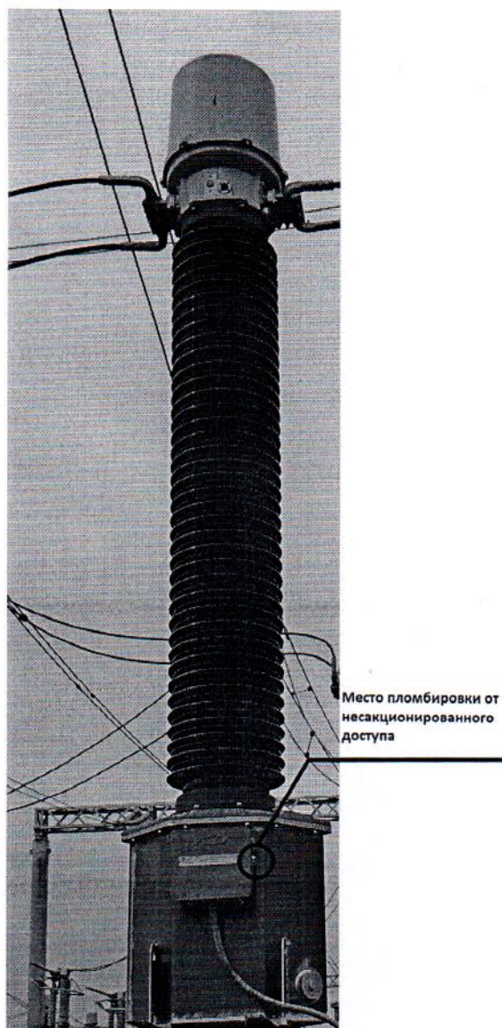
Рисунок 3 - Схема пломбировки от несанкционированного доступа
