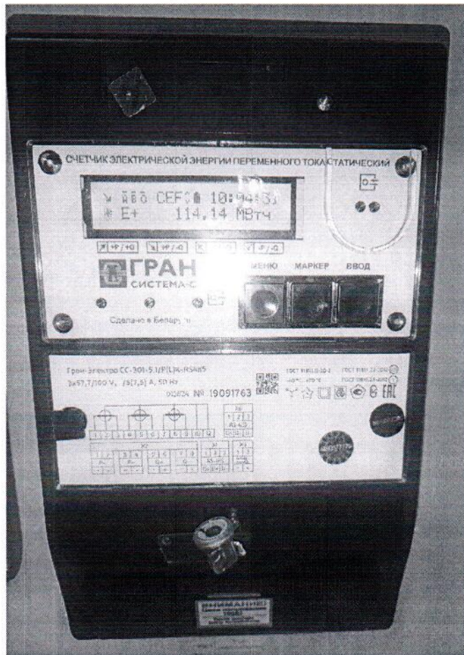
Рисунок 1.3 – Фотография компонентов АСКУЭ: счетчик электрической энергии «Гран-Электро СС-301»
