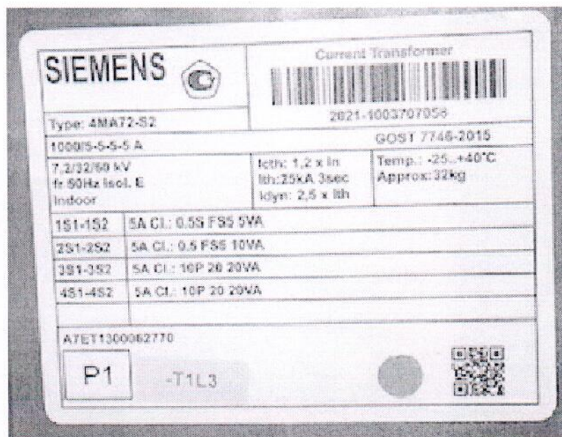
Рисунок 1.2 – Фотография маркировки трансформатора тока 4MA72-S2 АУС № 1003707058
