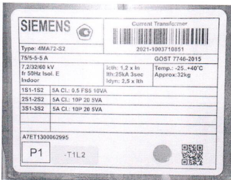
Рисунок 1.2 – Фотография маркировки трансформатора тока 4MA72-S2 АУС № 1003710851
