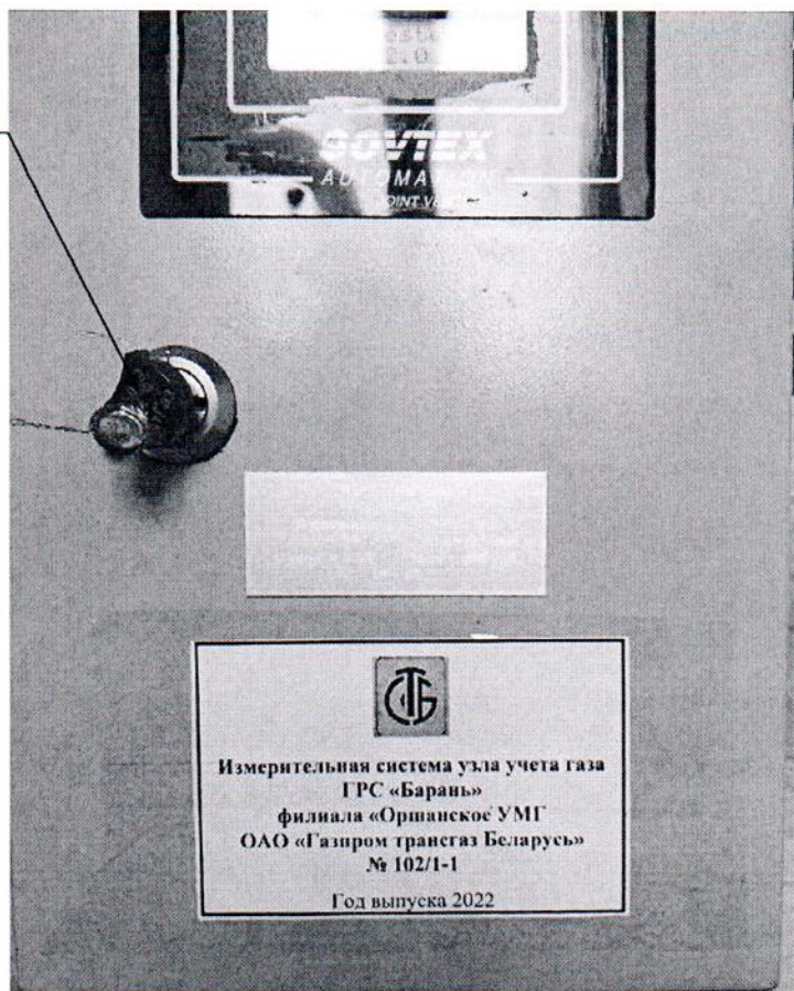
Рисунок 3.1 – Схема пломбировки от несанкционированного доступа
