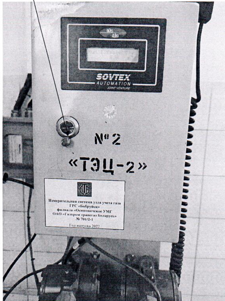
Рисунок 3.1 – Схема пломбировки от несанкционированного доступа
