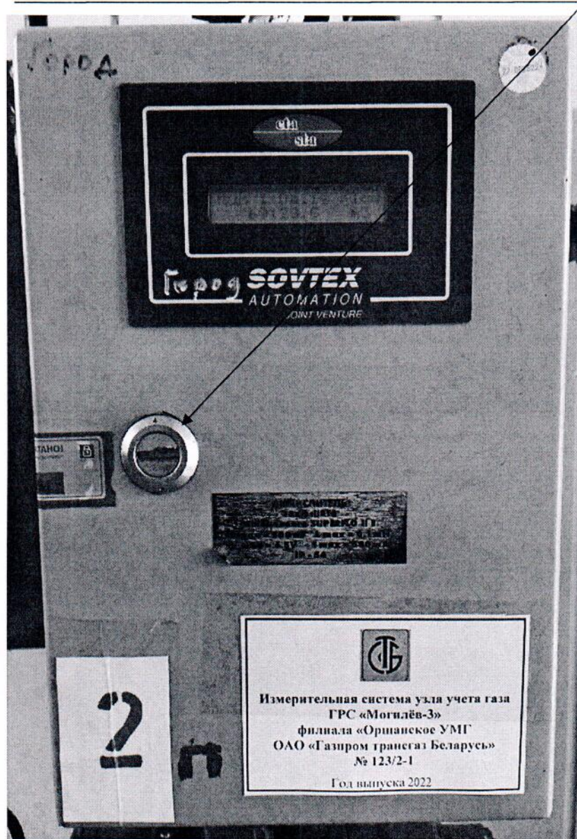
Рисунок 3.1 – Схема пломбировки от несанкционированного доступа
