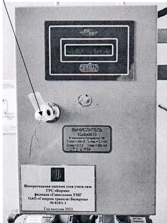
Рисунок 3.1 – Схема пломбировки от несанкционированного доступа
