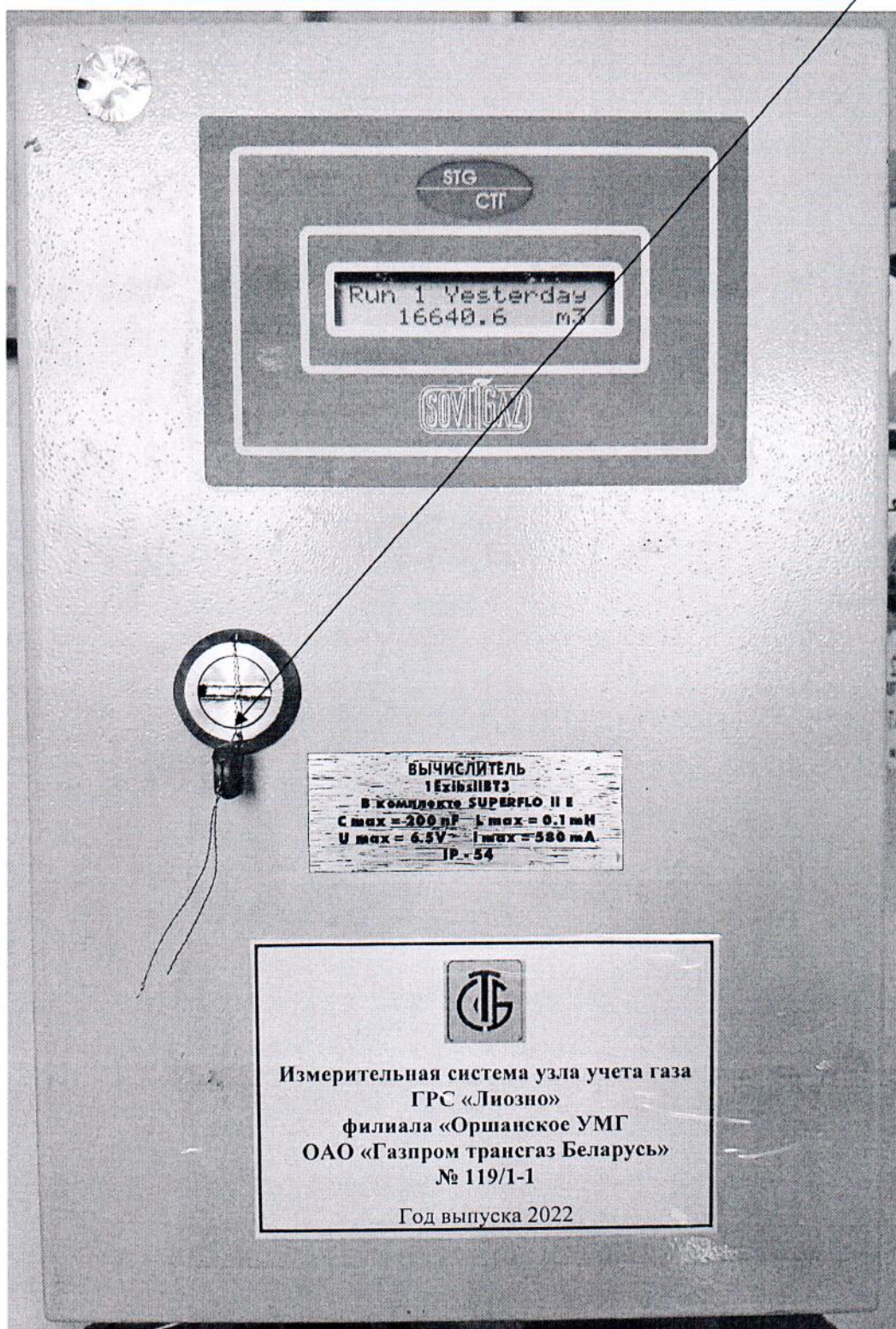
Рисунок 3.1 – Схема пломбировки от несанкционированного доступа
