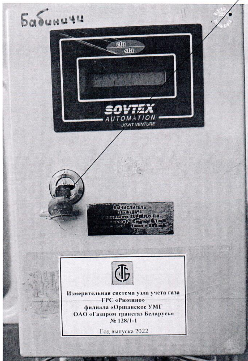
Рисунок 3.1 – Схема пломбировки от несанкционированного доступа
