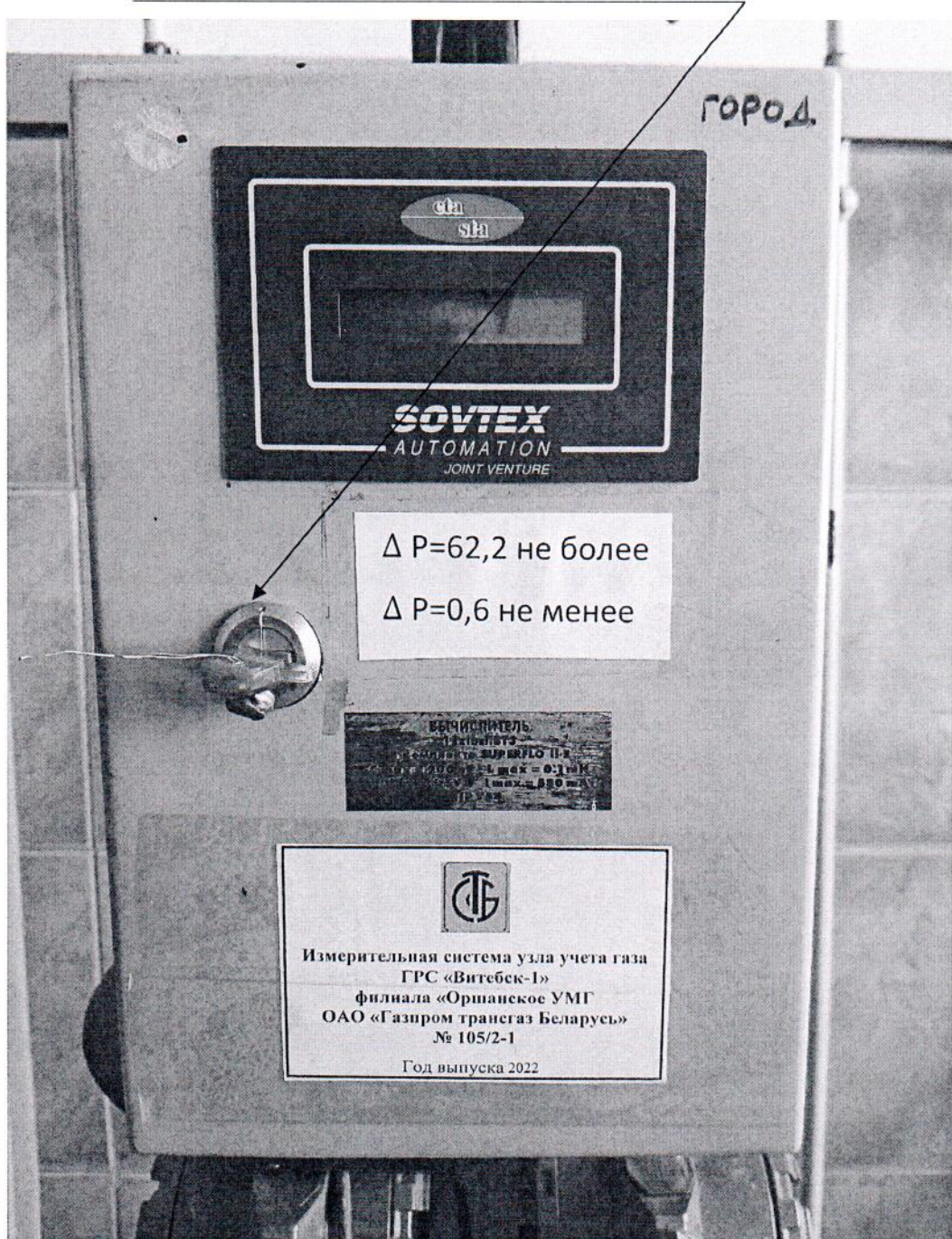
Рисунок 3.1 – Схема пломбировки от несанкционированного доступа
