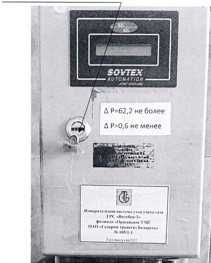
Рисунок 3.1 – Схема пломбировки от несанкционированного доступа
