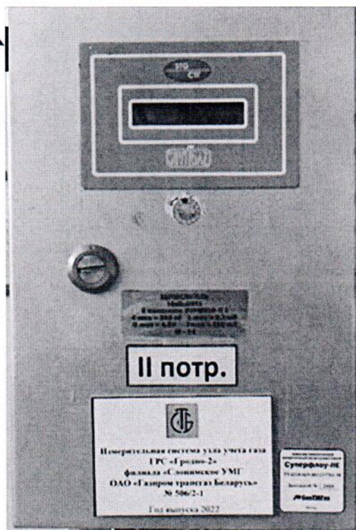
Рисунок 3.1 – Схема пломбировки от несанкционированного доступа
