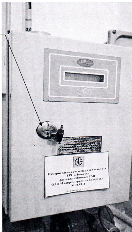
Рисунок 3.1 – Схема пломбировки от несанкционированного доступа
