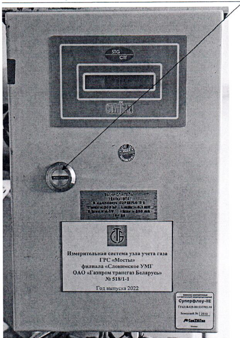
Рисунок 3.1 – Схема пломбировки от несанкционированного доступа
