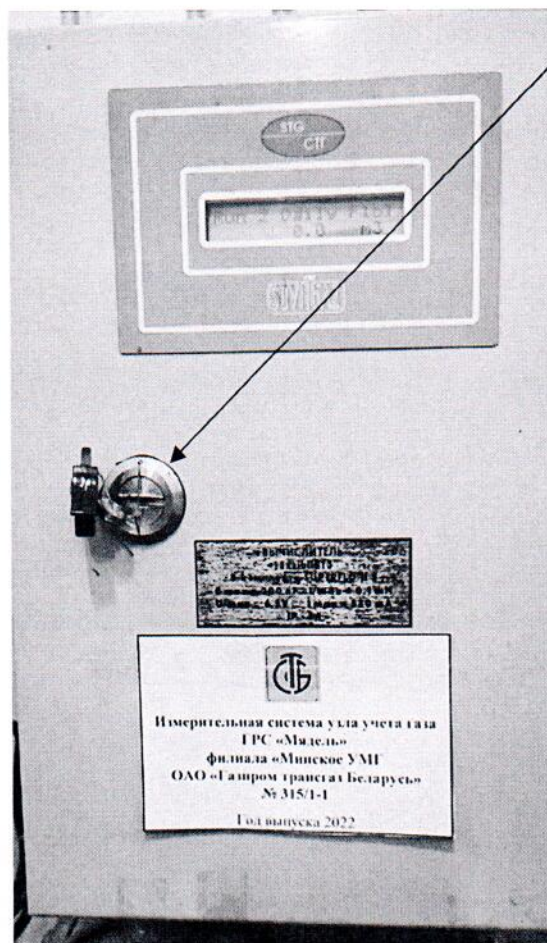
Рисунок 3.1 – Схема пломбировки от несанкционированного доступа
