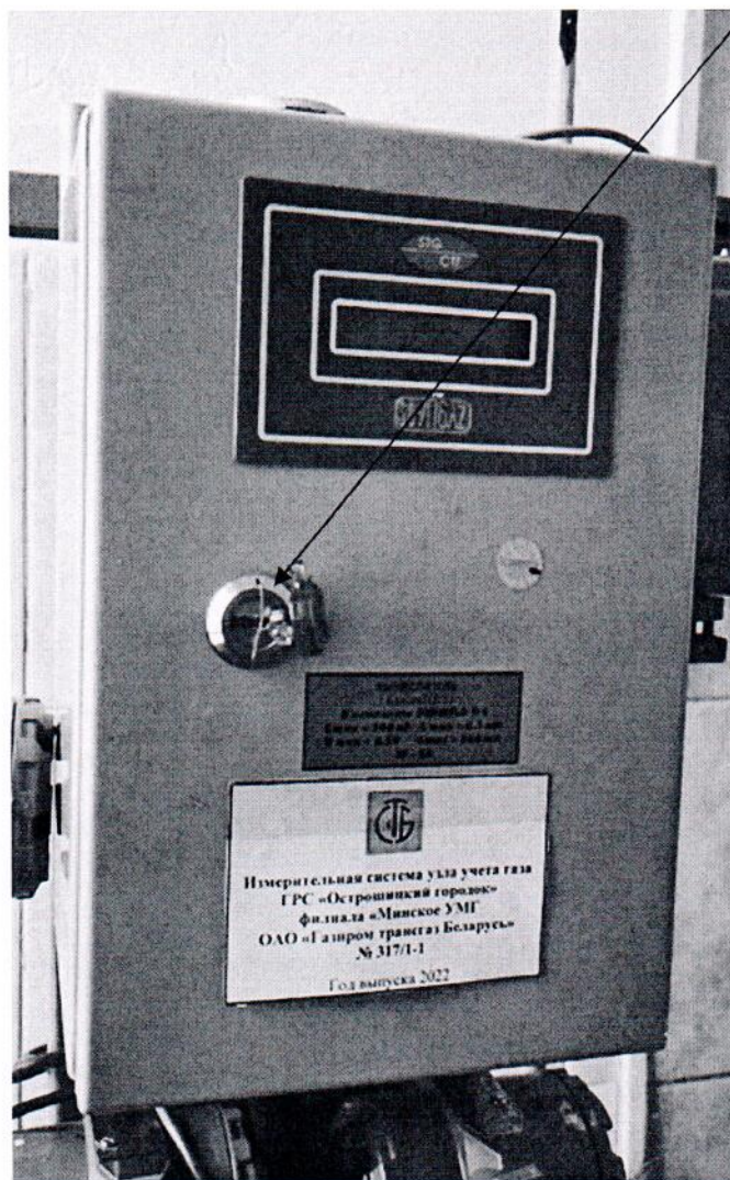
Рисунок 3.1 – Схема пломбировки от несанкционированного доступа
