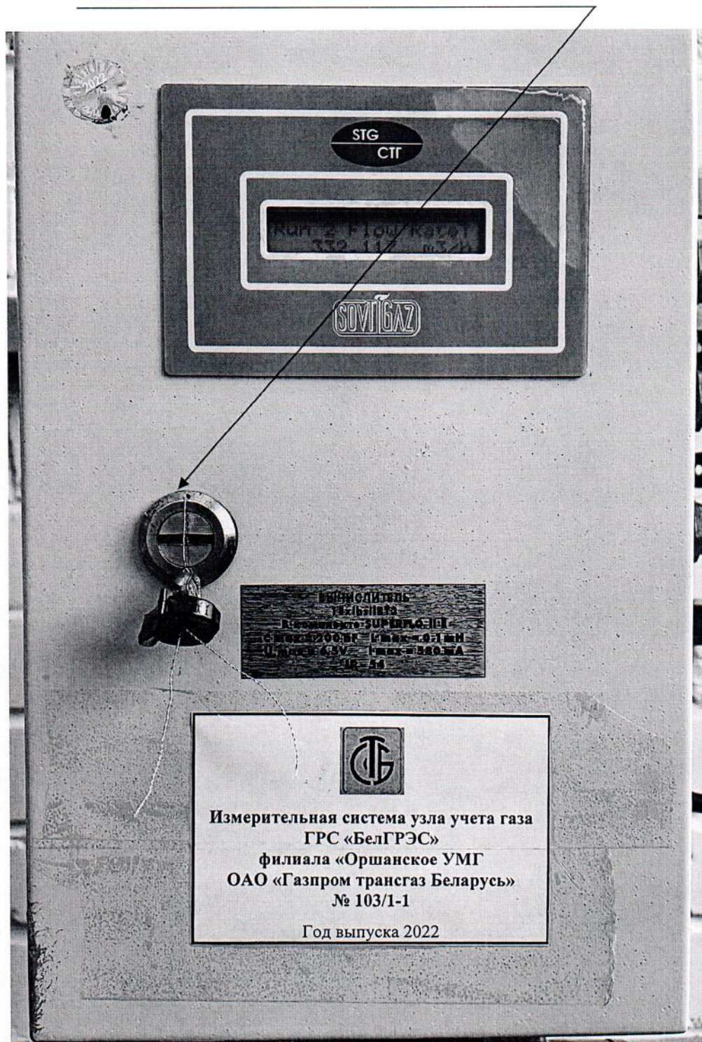
Рисунок 3.1 – Схема пломбировки от несанкционированного доступа
