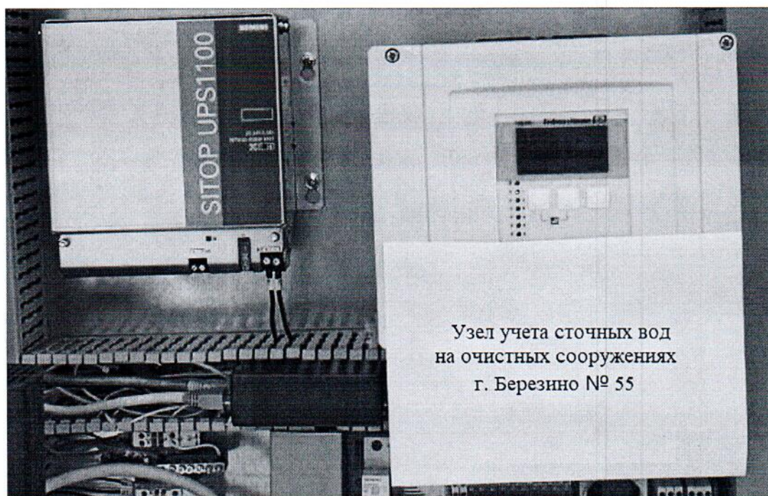
Рисунок 1.1 – Фотография общего вида вторичного преобразователя Prosonic S FMU90, № MA00F9010E6 уровнемера Prosonic входящего в состав узла учета
