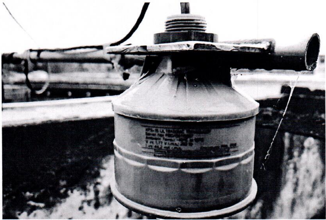
Рисунок 1.3 – Фотография общего вида ультразвукового преобразователя XPS-15 № PBD/D6115087 входящего в состав узла учета
