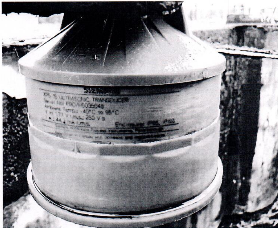
Рисунок 1.3 – Фотография общего вида ультразвукового преобразователя XPS-15 № PBD/H5035048 входящего в состав узла учета
