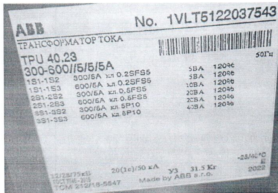
Рисунок 1.2 – Фотография маркировки трансформатора тока TRU 40.23 № 1VLT5122037543
