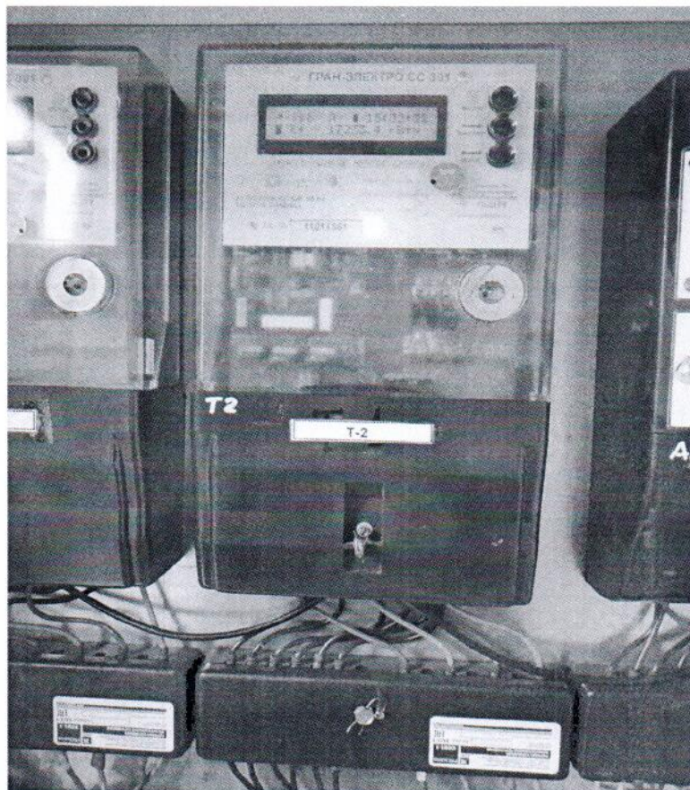
Рисунок 2 – Фотография компонентов АСКУЭ при применении счетчиков электрической энергии переменного тока трехфазных статических СС-301.
