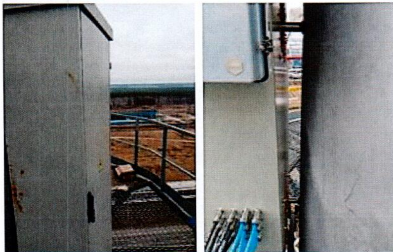
Рисунок 1.3 – Фотографии общего вида блока измерительных приборов с измерителем скорости газозадушного потока инфракрасным VCEM5100 системы газоаналитической промышленной взрывозащищенной PromIS GA Ex № 292
