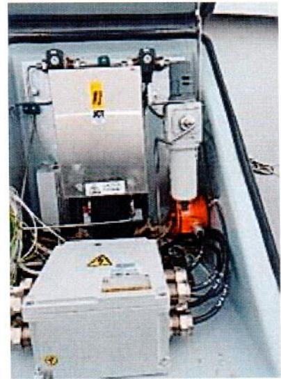
Рисунок 1.2 – Фотография общего вида пробоотборного зонда JES-301, расположенного в шкафу системы газоаналитической промышленной взрывозащищенной PromIS GA Ex № 292
