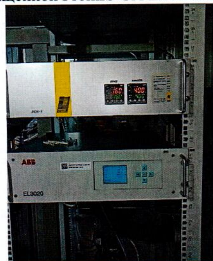
Рисунок 1.6 – Фотографии общего вида газоанализатора многоканального EL3020 с аналитическими модулями Uras26 и Magnos28 системы газоаналитической промышленной взрывозащищенной PromIS GA Ex № 292
