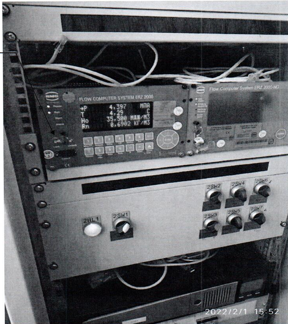
Рисунок 3.1 – Схема пломбировки от несанкционированного доступа
