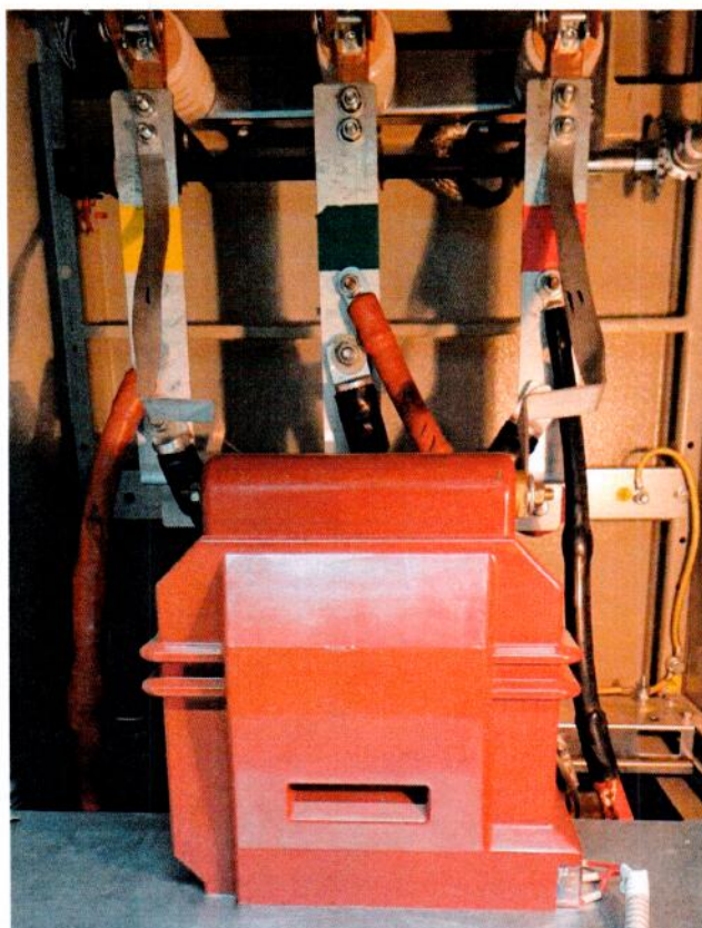
Рисунок 4 – Фотография компонентов АСКУЭ при применении трансформатора напряжения ЗНОЛП-НТЗ-10
