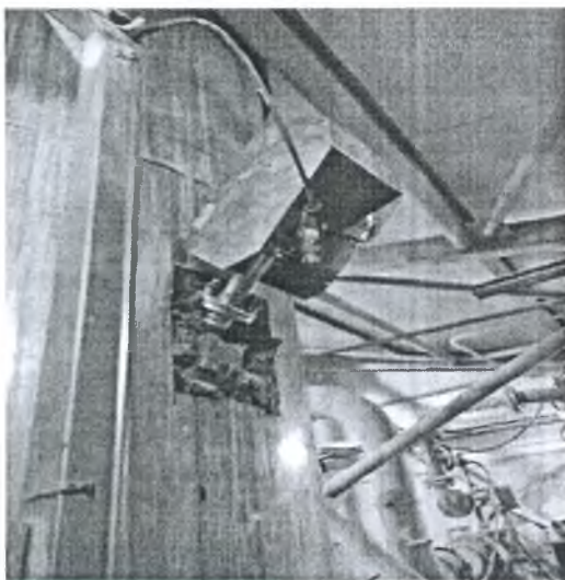
Фотография 4 – Измеритель скорости ультразвуковой FLOWSIC100H.
