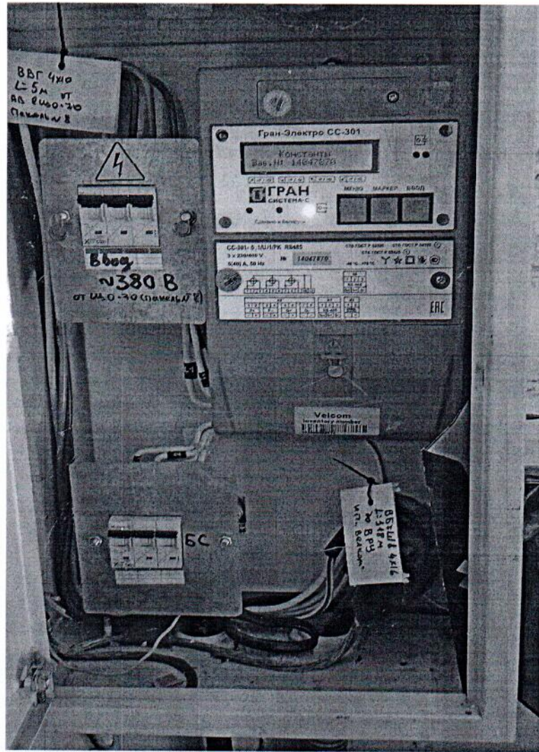
Рисунок 2 – Фотография компонентов АСКУЭ при применении счетчика электрической энергии «Гран-Электро СС-301»
