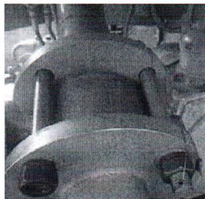
Рисунок 4 – Место пломбирования крана шарового
