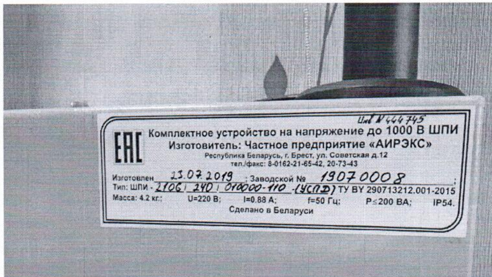
Рисунок 1 – Фотографии компонентов АСКУЭ. УСПД ШПИ ЧП «АИРЭКС»
