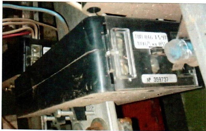
Трансформаторы тока ТШП-0,66-1-5 УЗ
