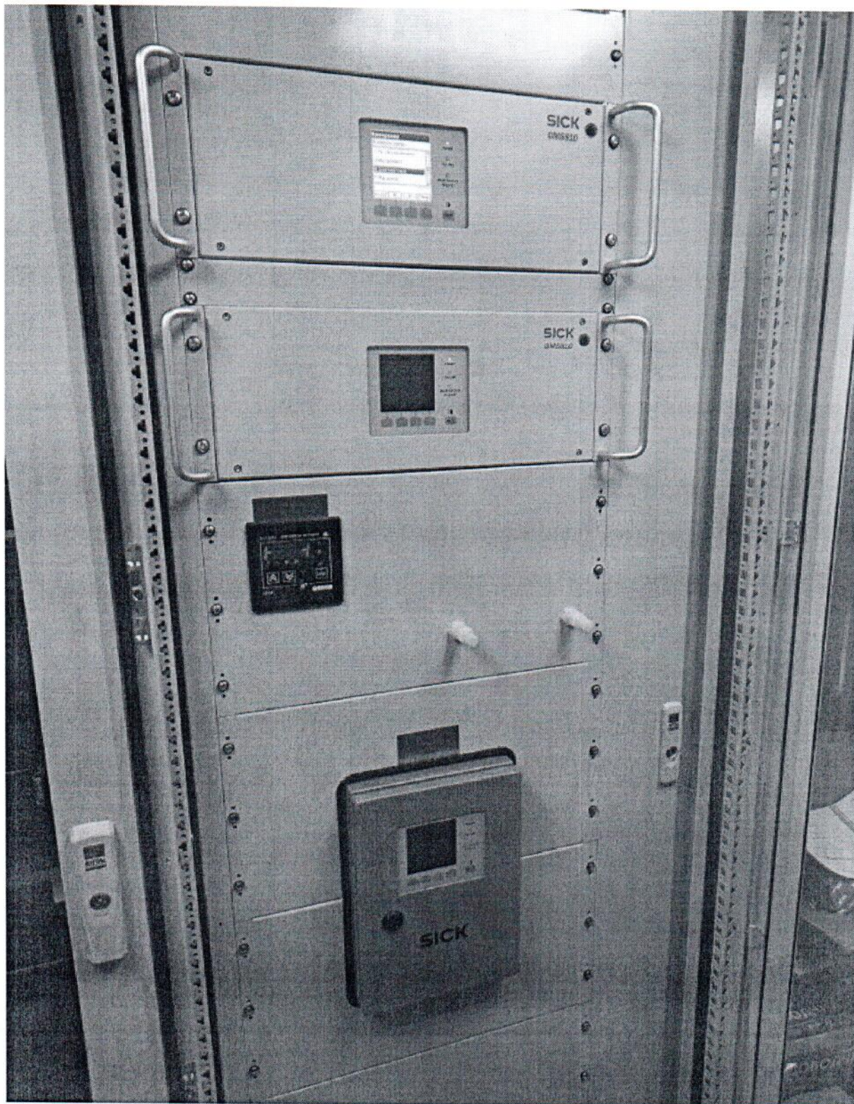
Фотография общего вида системы газового анализа АСКВ
