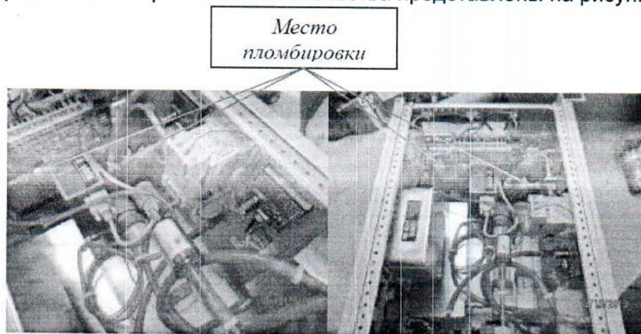
Рис. 2 – Схема пломбирования расходомера-пробоотборника
