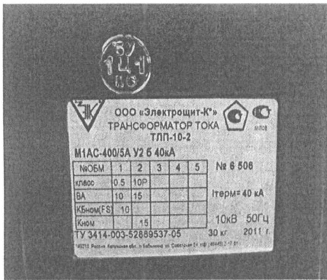
Рисунок 2 – Место нанесения паспортной таблички, поверительного клейма и знака утверждения типа
