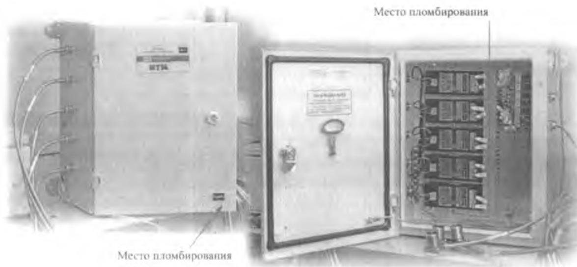
Рисунок 1 – Шкафы с измерительными преобразователями
