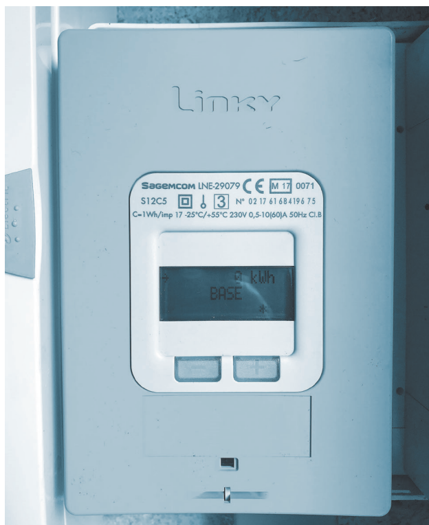
Рис. 1. Современный «интеллектуальный» электрический счетчик (Linky)
